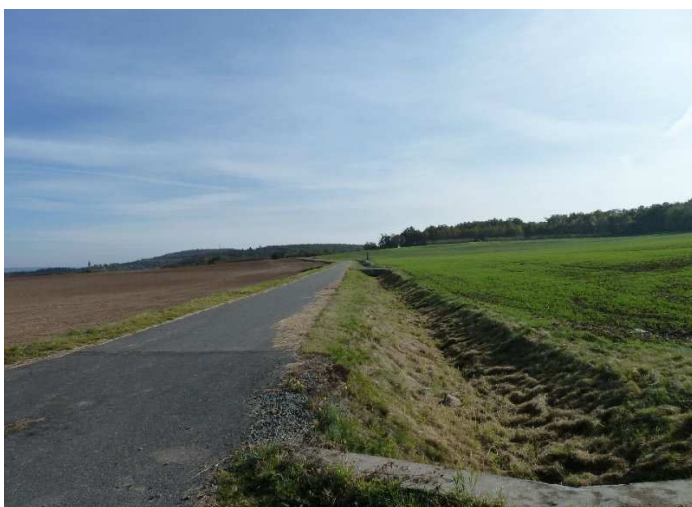
Obr. č. 6: Hlavní polní cesta s doprovodným příkopem
