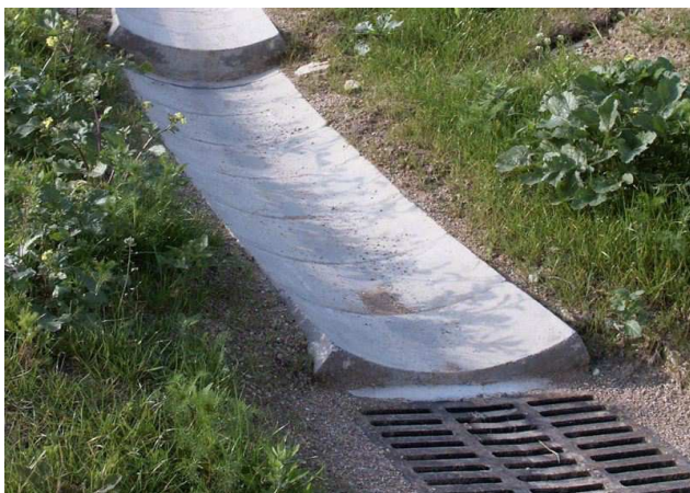
Obr. č. 7: Svodný žlábek
