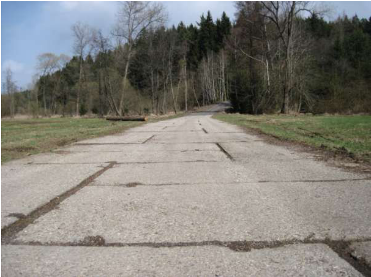
Obrázek 14 – Panelová vozovka v záplavové oblasti
