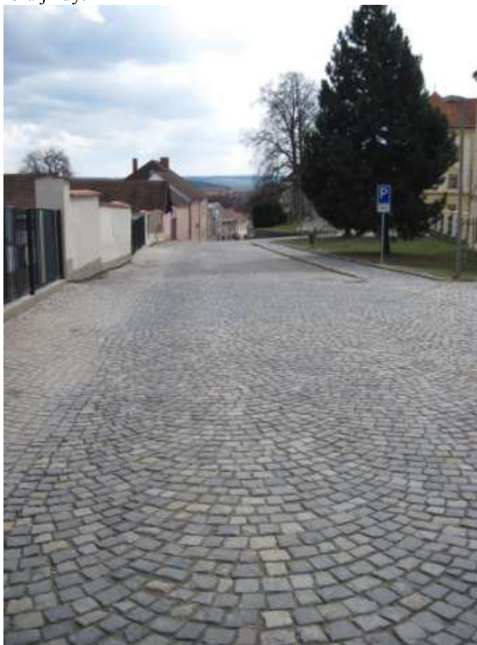
Obrázek 12 – Vozovka ze žulových kostek
