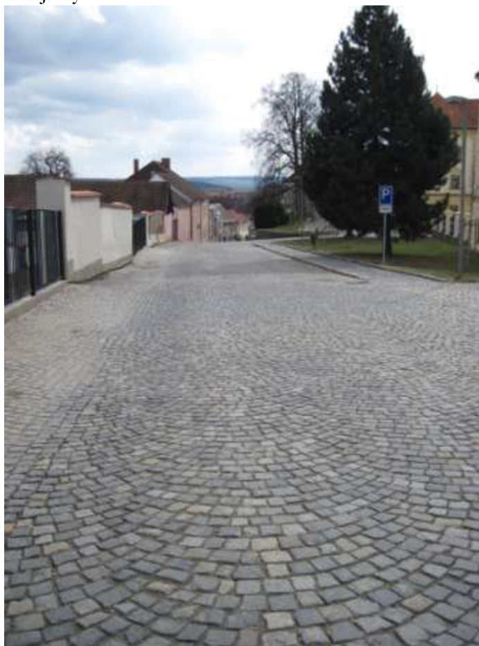
Obrázek 12 – Vozovka ze žulových kostek
