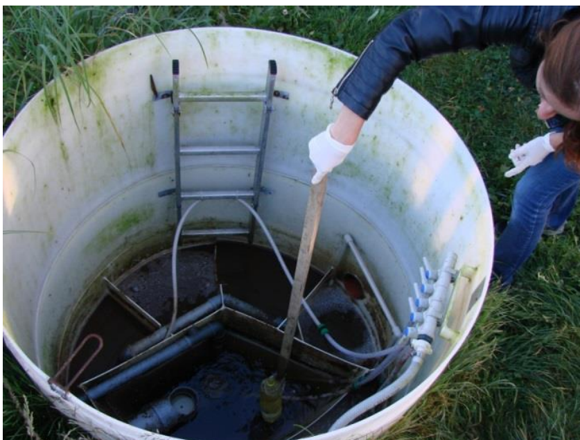
Obr. č. 10: Odběr vzorku odpadní vody z usazovací části (Foto: Krábková)
