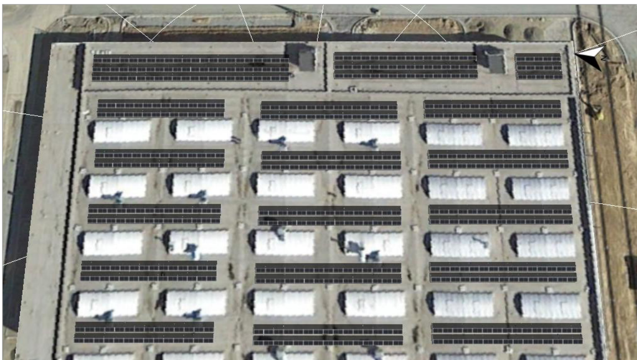
Obrázek: 3. Umístění modulu - Hala střed-Module Area West
