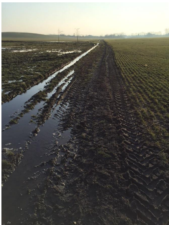
Obr. 20: Stav příjezdové cesty
