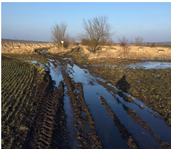
Obr. 21: Stav příjezdové cesty
