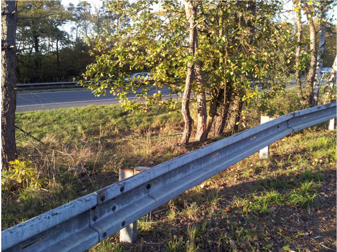
Foto. č. 7: Narušená integrita oplocení. Zdroj: Novák Libor.
