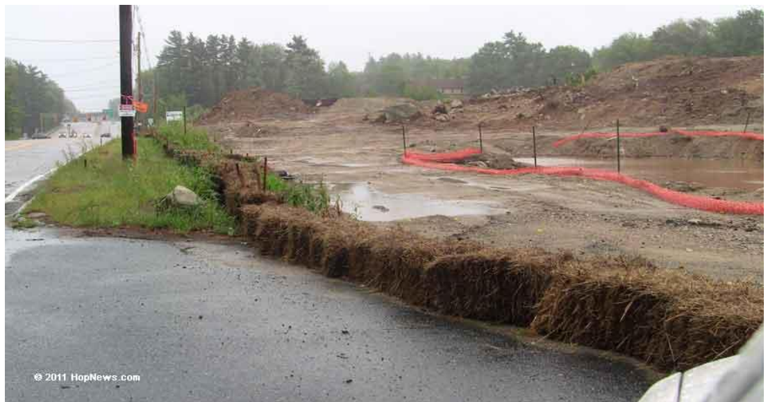
Obr. 8: Balíky slámy jako protierozní opatření (HopNews.com, 2011)
