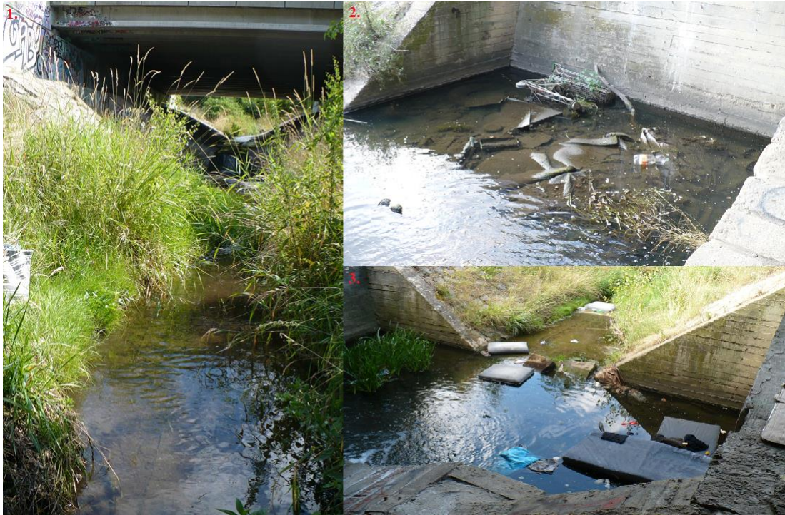
Obr. č. 24: 1 - lokalita č. 7 pro odběr vzorků vody v pohledu proti proudu; 2, 3 – černá skládka v toku pod mostem silnice Chlumecká.
