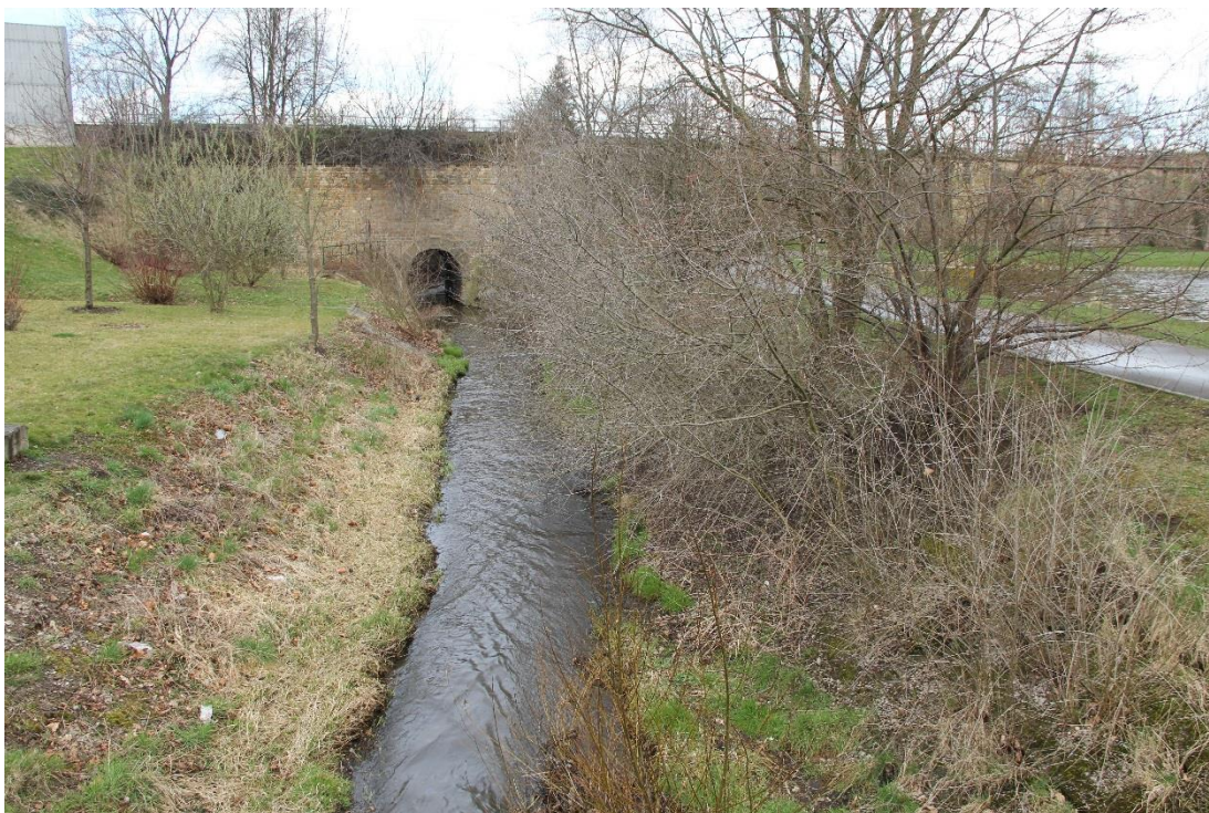
obr. 9 – koryto Litovického potoka (autor)
