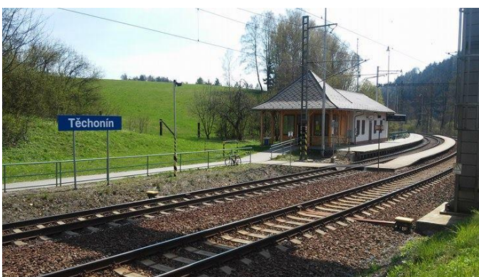
Obrázek 6 – Zastávka Těchonín, po rekonstrukci (vlastní fotografie)
