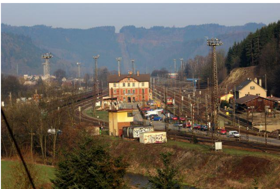
Obrázek 11 – Pohled na stanici Ústí nad Orlicí, před rekonstrukcí
