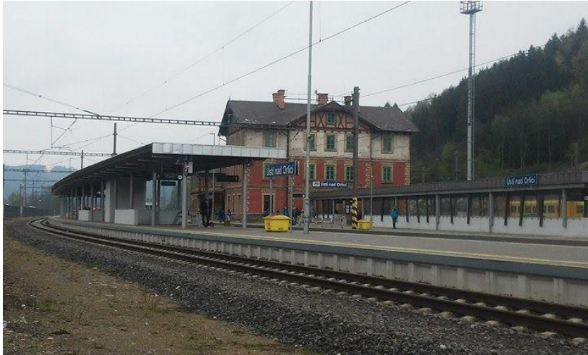
Obrázek 12 – Pohled na stanici Ústí nad Orlicí, po rekonstrukci (vlastní fotografie)
