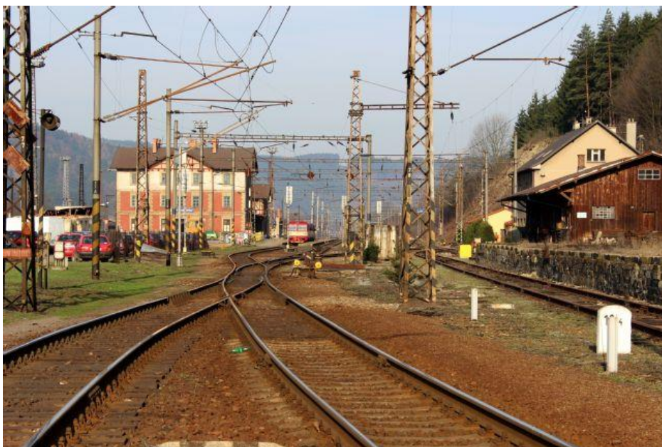
Obrázek 10 – Stanice Ústí nad Orlicí, před rekonstrukcí
