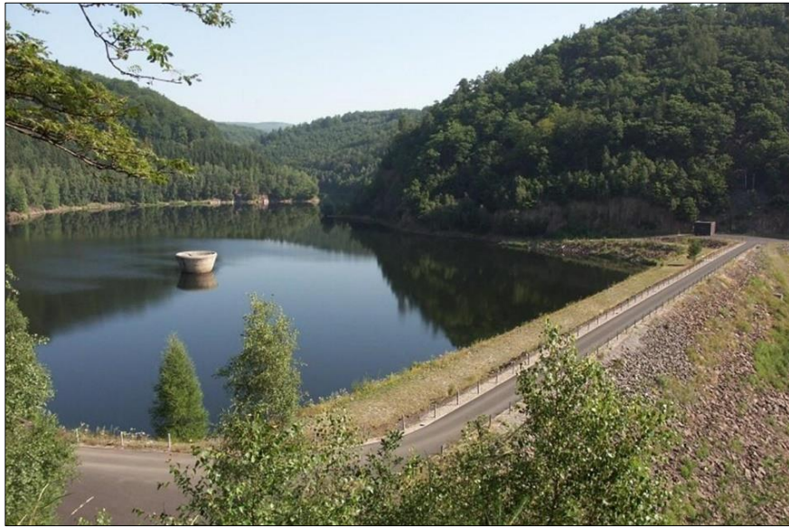
Obr. 17: Hráz a šachtový bezpečnostní přeliv (POh, 2019).
