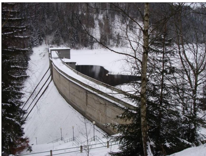
Obr. 9: Těleso hráze s klenutím (autor, 2021).
