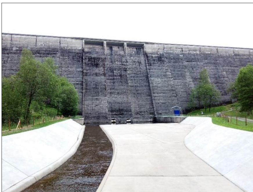
Obr. 13: Těleso hráze s přepadem, skluzem a vývarem (autor, 2019).
