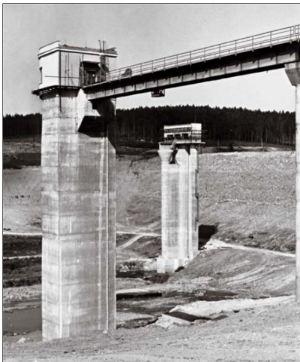
Obr. 20: Stavba funkčního a odběrového objektu (POh, ©2021).
