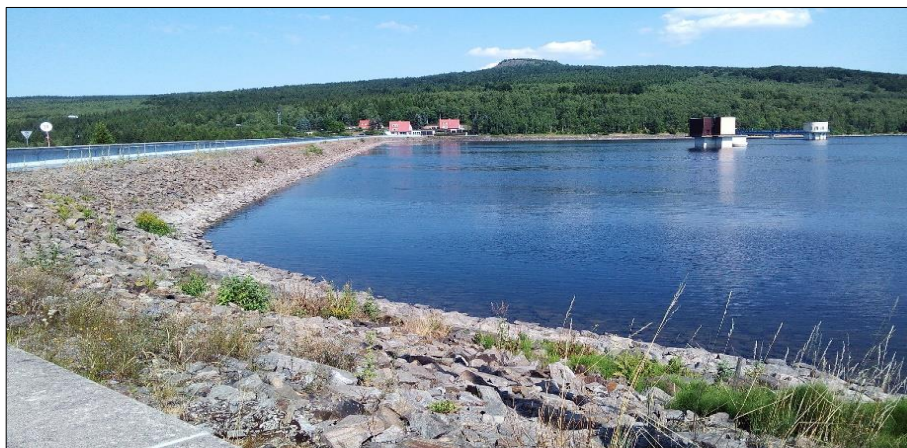
Obr. 21: Těleso hráze v pozadí s věžovými objekty (autor, 2019).
