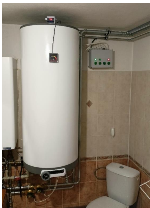
Obrázek 2.9 Instalace bojleru v koupelně
