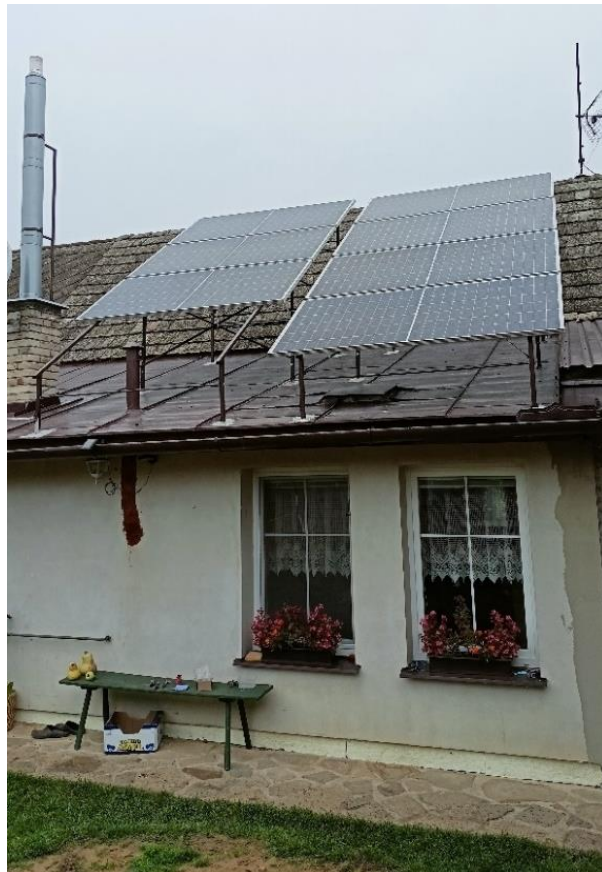
Obrázek 2.8 Finální instalace FV modulů na střeše objektu
