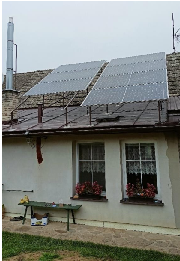
Obrázek 2.8 Finální instalace FV modulů na střeše objektu
