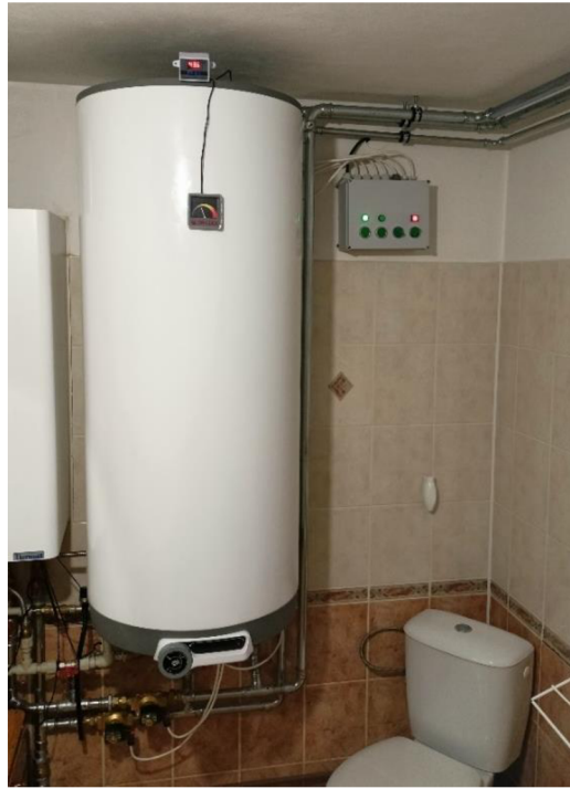
Obrázek 2.9 Instalace bojleru v koupelně
