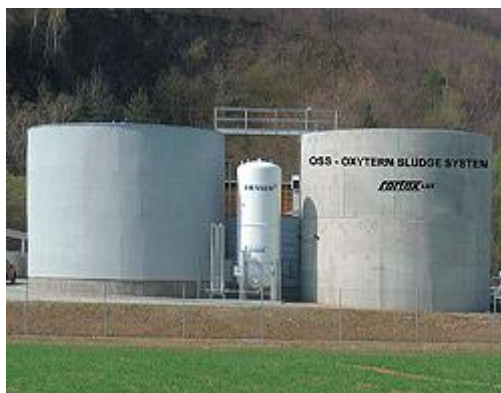
Obr. č. 12 Zařízení pro autotermní termofilní stabilizaci (Fortex ags 2011)
