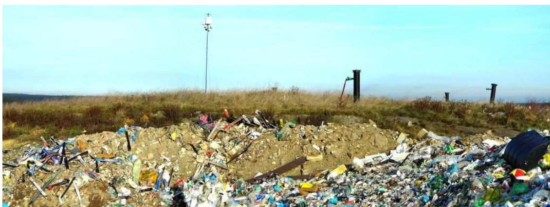
Foto č. 4 – Pohled na vrchní část skládky s komínovými hlavicemi pro odvod skládkového plynu
