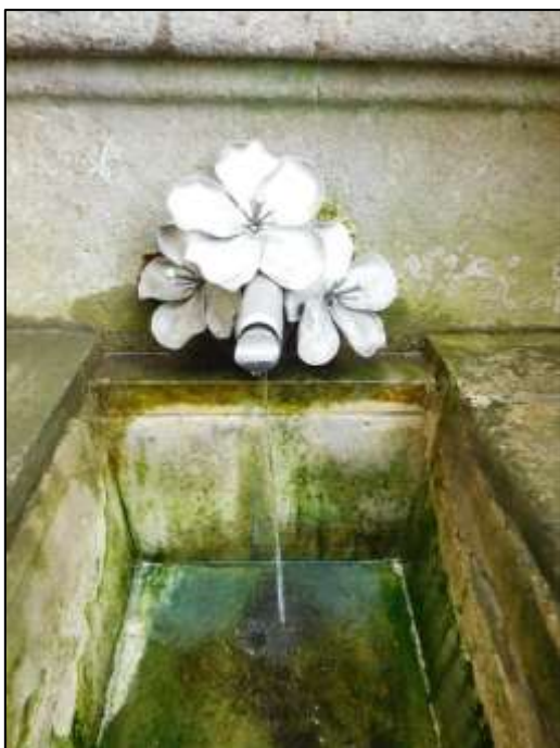
Obr. 35. Kovové vyústění pramene před kaplí. (zdroj: Majerová, 2016)
