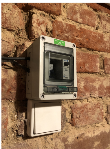
Obrázek 4.6. Z-Wave spínač elektrického kotle
