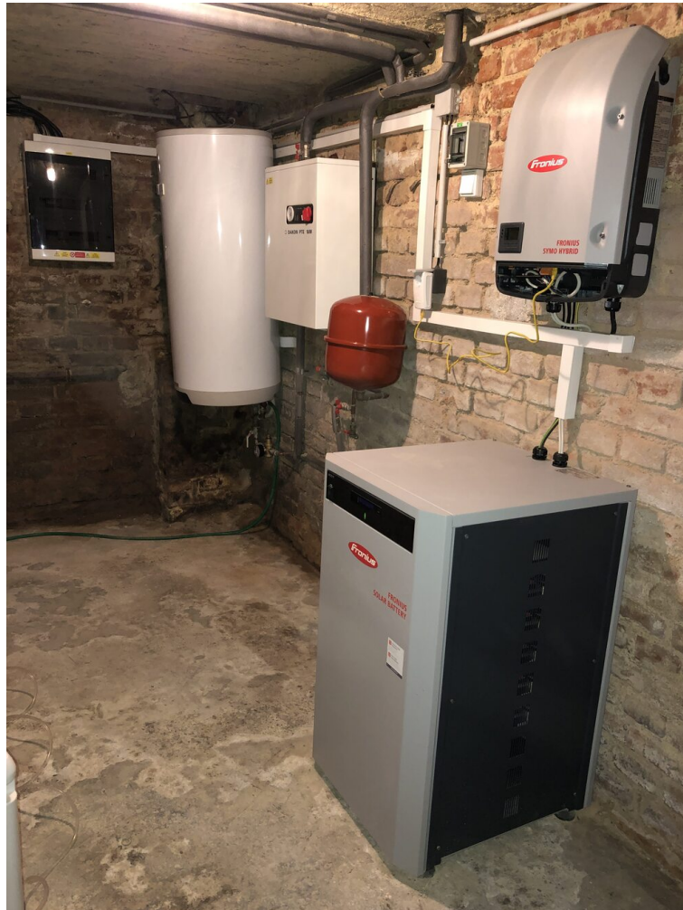
Obrázek 3.4. Jistič, bojler, elektrokotel, baterie a střídač
