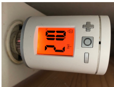
Obrázek 4.2. Z-Wave termostat na radiátoru
