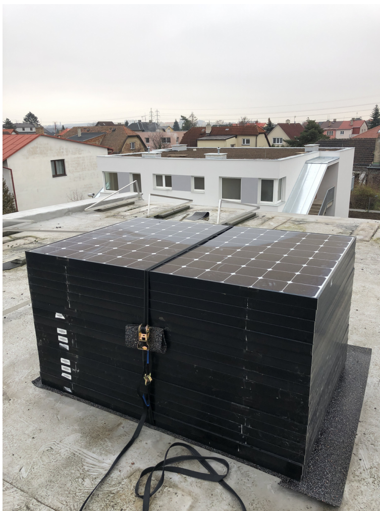
Obrázek C.7. Demontované solární panely při kontrole poškození střechy
