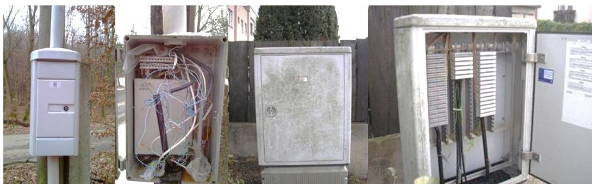
Obrázek 6: Příklady telefonních rozvaděčů UR a SR
