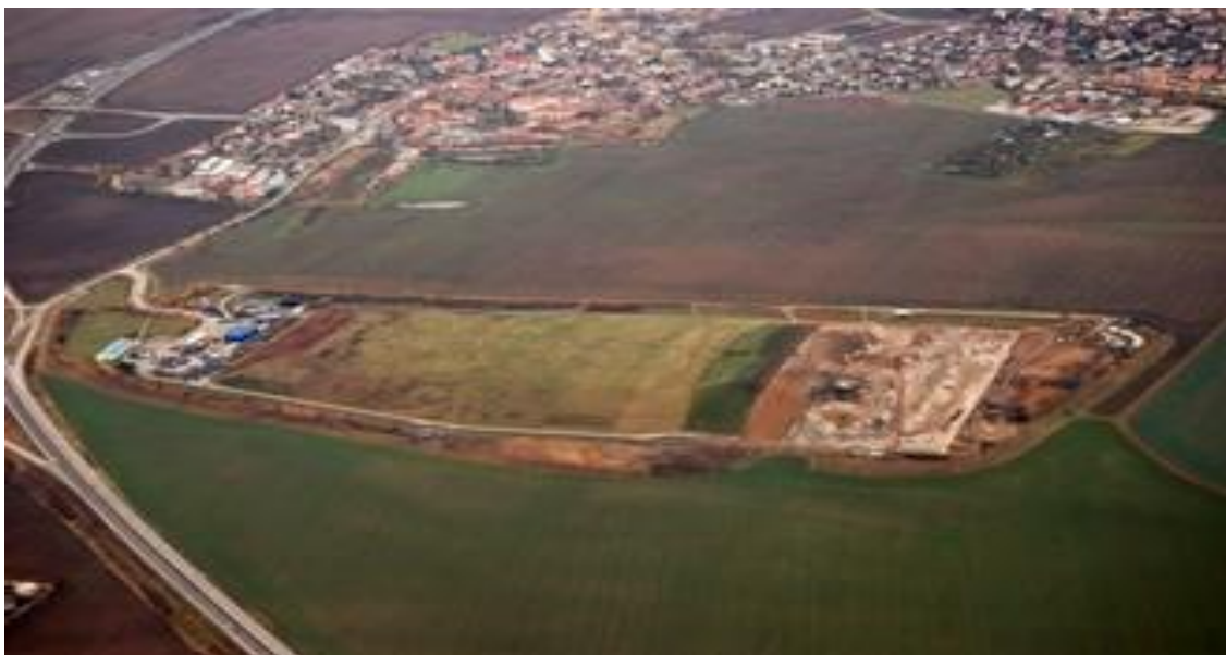
Obr.č. 3: Skládka v Ďáblicích
