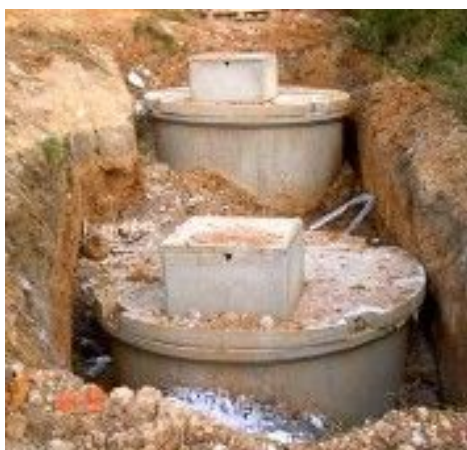
Obr. 16 Betonové válcové nádrže [1]
