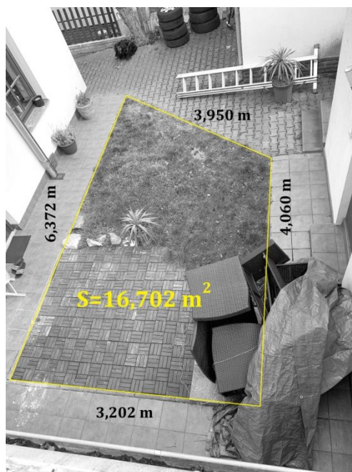
Obr. 33 Plocha pro instalaci akumulční nádrže [zdroj autor]
