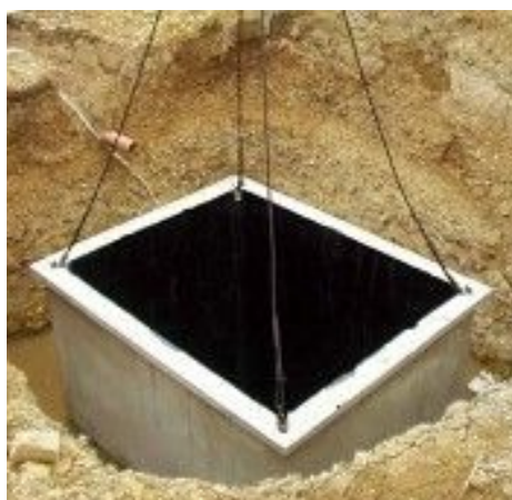
Obr. 17 Usazování betonové nádrže [1]
