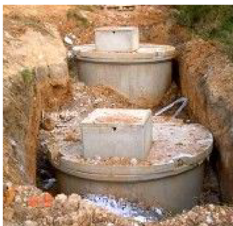
Obr. 16 Betonové válcové nádrže [1]
