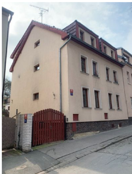
Obr. 26 Severní strana rodinného domu [zdroj autor]
