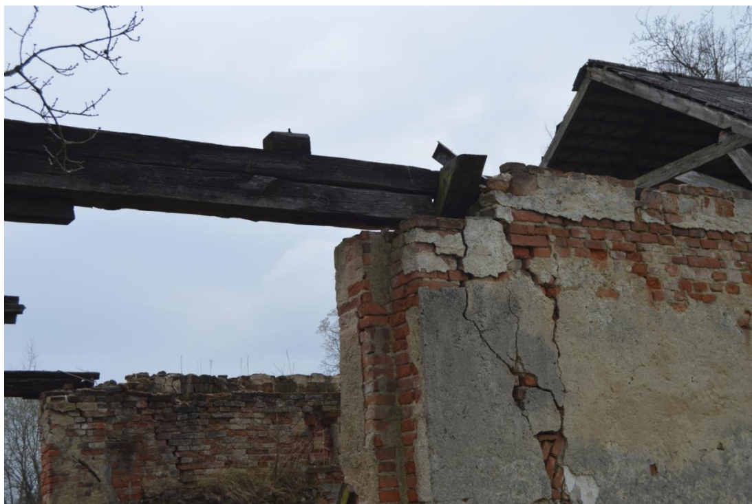
Foto č. 9 – Ukázka překladu, který je tvořený pozednicí (zdroj: vlastní)
