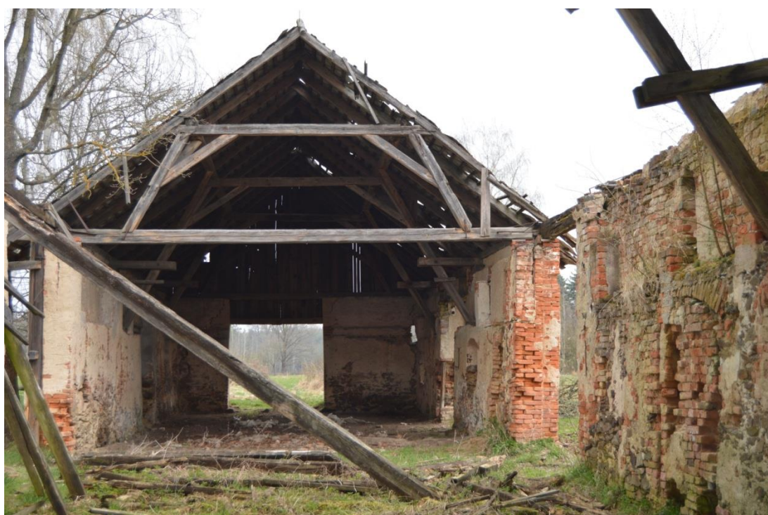
Foto č. 8 - Vnitřní pohled skladu suché píče (zdroj: vlastní)
