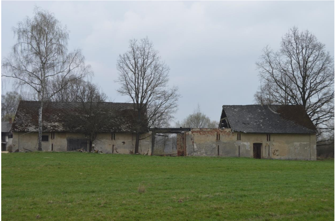
Foto č. 3 – Severozápadní pohled skladu suché píce (zdroj: vlastní)
