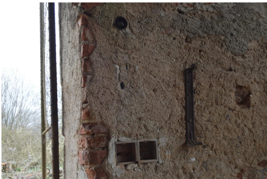
Foto č. 12 – Důkaz existence stávajících rozvodů elektřiny (zdroj: vlastní)
