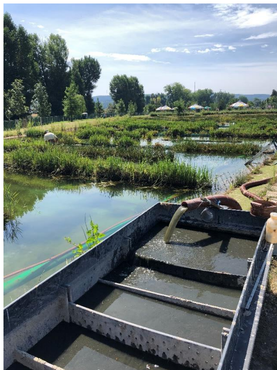
Obr.3: Usazovací box při procesu čištění dna nádrže (Michal Ševčík, 2020)
