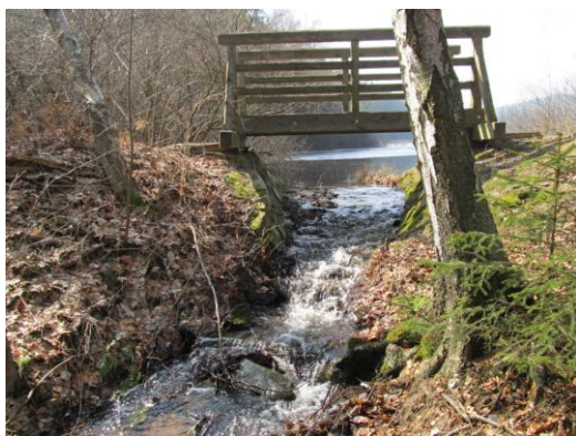
Obr. 12: Odtok vody do Řásenského potoka (foto: autor, 2012)
