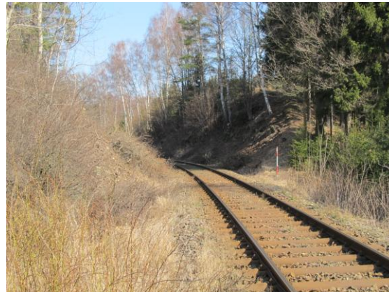
Obr. 15: Průkop u Salavice (foto: autor, 2012)
