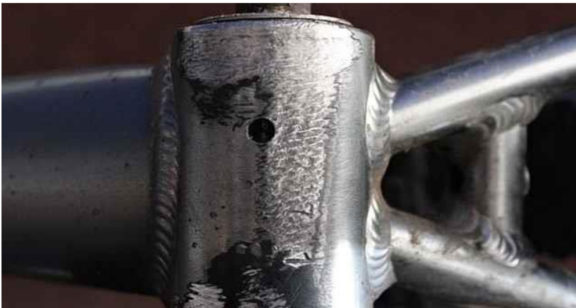
Obr. č. 9: Ukázka částečně vypilovaného vyraženého výrobního čísla pachatelem na rámu jízdného kola. Zdroj: ( https://prazsky.denik.cz/zlociny-a-soudy/podezrele-chytili-pri-brouseni-vyrobnich-cisel-kol-20150604.html ).
