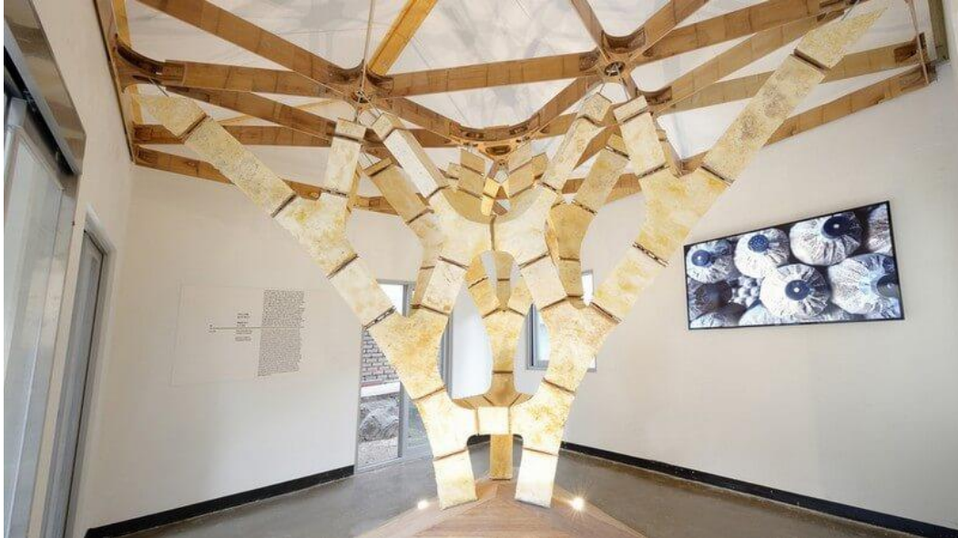
Obrázek 4: Prostorová konstrukce z nosných prvků mycelia "MycoTree".
