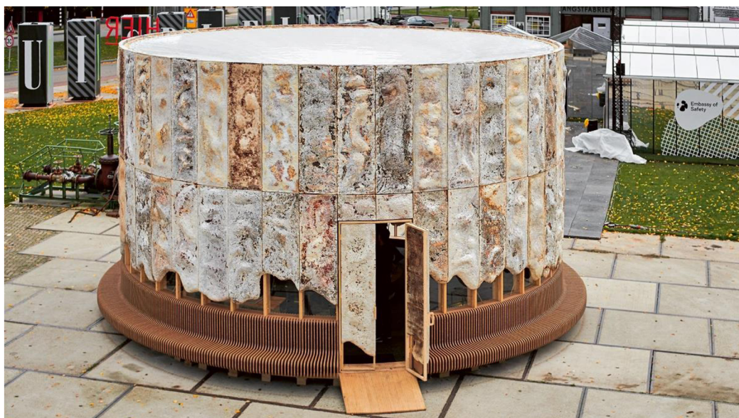
Obrázek 3: Pavilon "Hy-Fi" s použitím cihel z mycelia Philipa Rosse.
