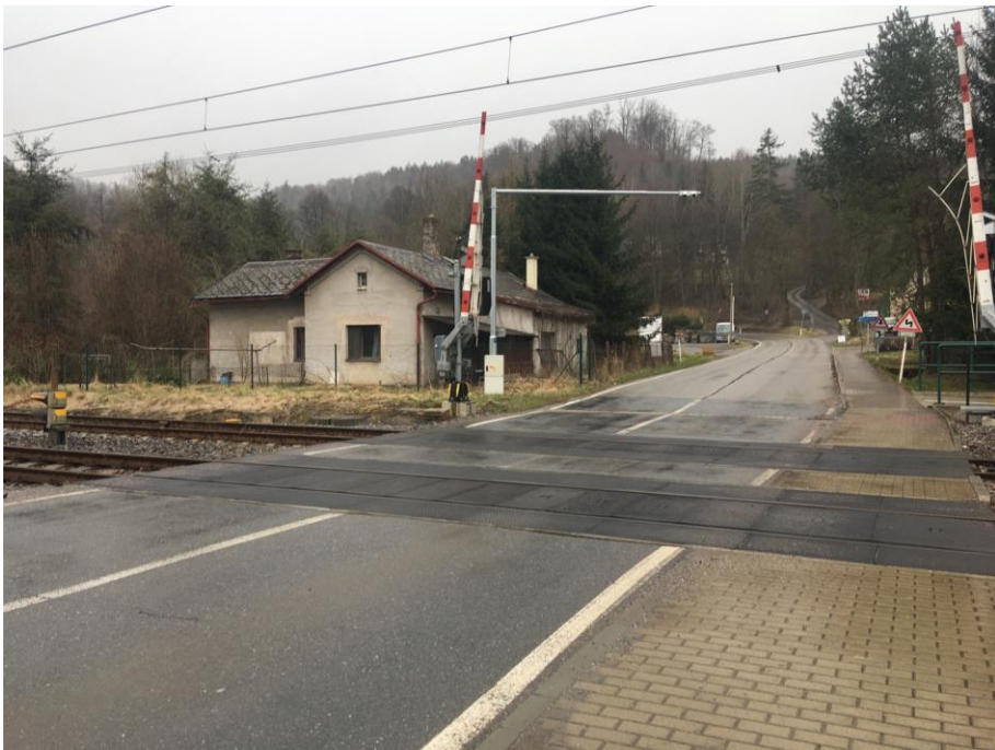
Obr. 20. Železniční přejezd v Hnáticí (Autor, 2022)
