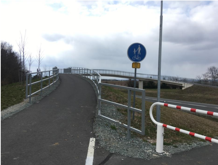
Obr. 30. Nadjezd přes hlavní silnici na trase v Opočně (Autor, 2022)
