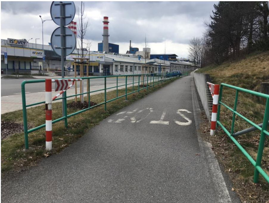
Obr. 36. Závory na cyklostezce v Častolovicích (Autor, 2022)
