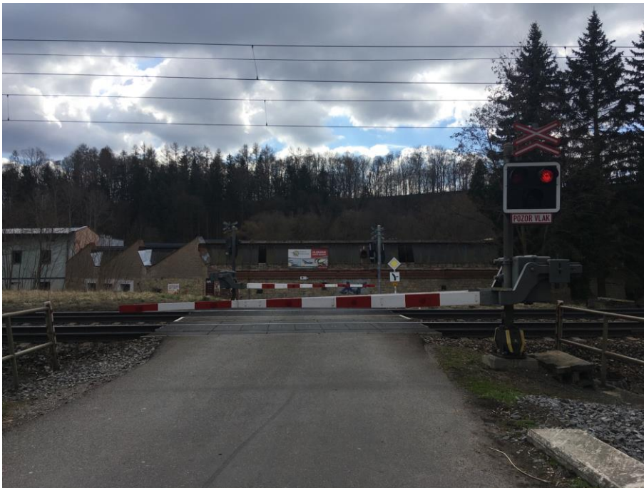
Obr. 13. Železniční přejezd v Pelinách (Autor, 2022)
