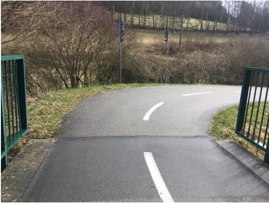
Obr. 19. Nájezd na most mezi Lanšperkem a Hnáticí (Autor, 2022)
