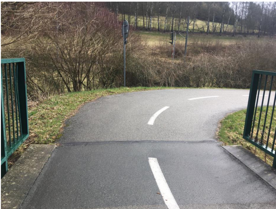
Obr. 19. Nájezd na most mezi Lanšperkem a Hnátnicí (Autor, 2022)
