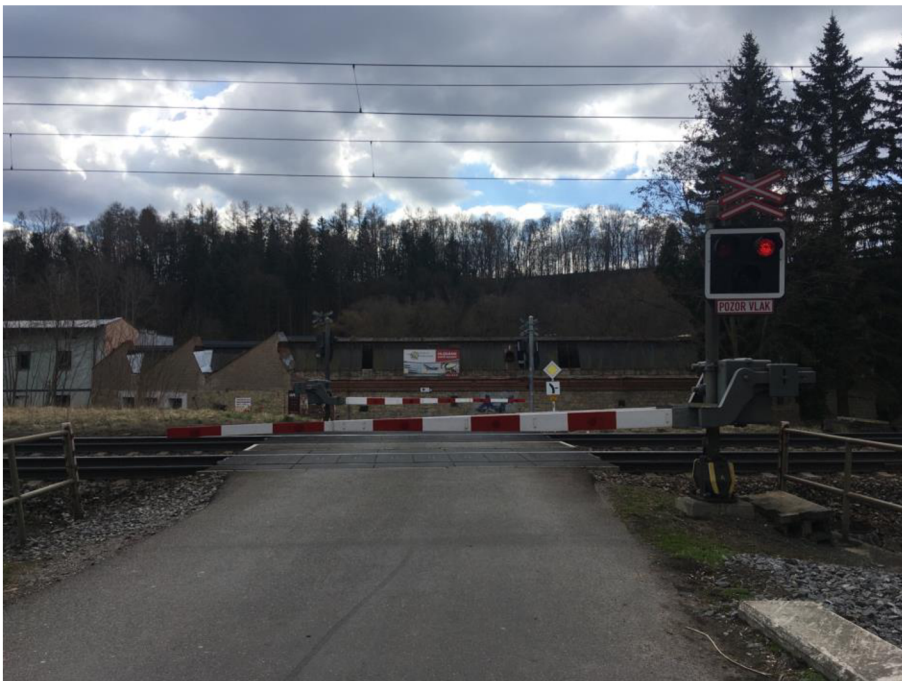
Obr. 13. Železniční přejezd v Pelinách (Autor, 2022)
