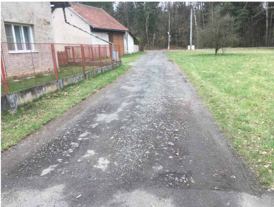
Obr. 41. Stav komunikace za autobusovou zastávkou Křivice, hřiště (Autor, 2022)
