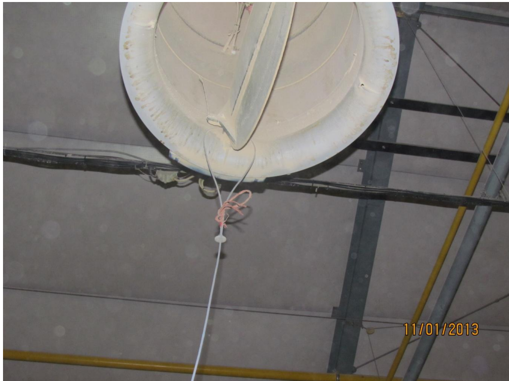
Obrázek 25 Sonda u nasávacího komínu ventilátoru (Ing. Antonín Dolan)
