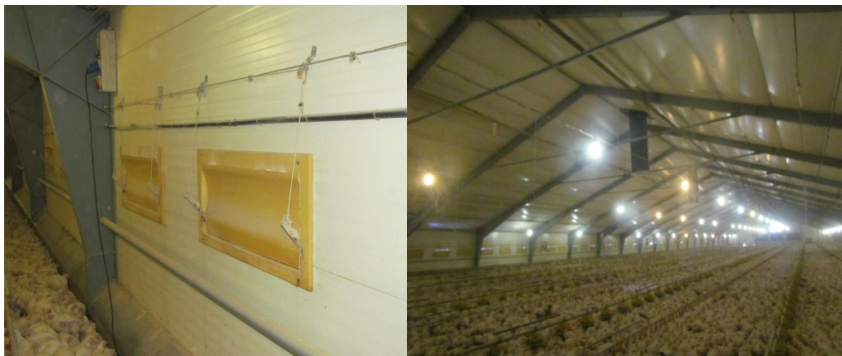
Obrázek 20 Štěrbiny pro přívod vzduchu (vlevo) a stropní ventilátory (vpravo), (Ing. Antonín Dolan)
