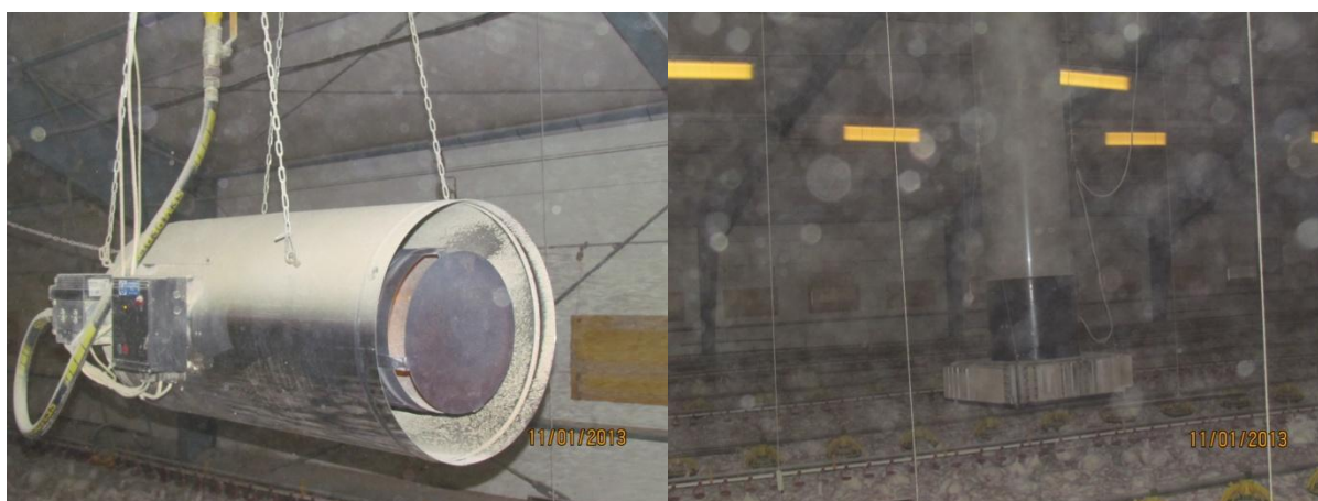
Obrázek 21 Plynový agregát (vlevo) ventilátor (vpravo), (Ing. Antonín Dolan)
