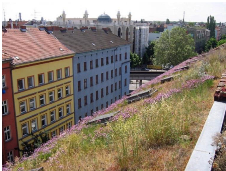
Obr. 3: Moderní extenzivní zelená střecha v Berlíně-Kreuzbergu (Köhler et Poll 2010)
