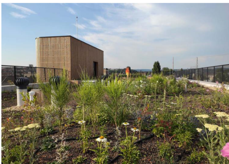
Obr. 7: Intenzivní střecha; Green Ville, Brno, Česko (Greenville ©2013)
