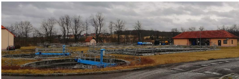
Obrázek 11: Čistírna odpadních vod Dobříš
