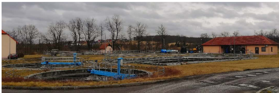
Obrázek 11: Čistírna odpadních vod Dobříš
