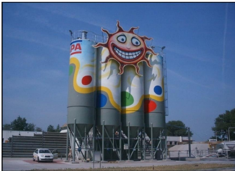
Obr. č. 70: Betonárna ZAPA beton a.s. [45]
