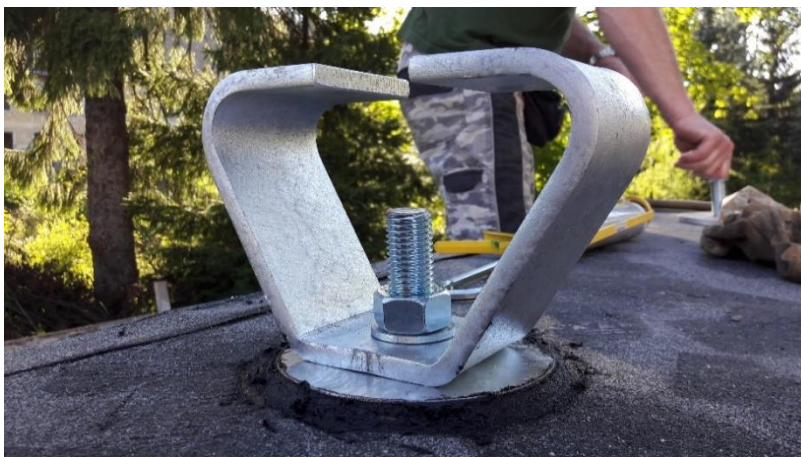
Obr. č. 14: Kotvení římsy pomocí tzv. motýlků [2]
