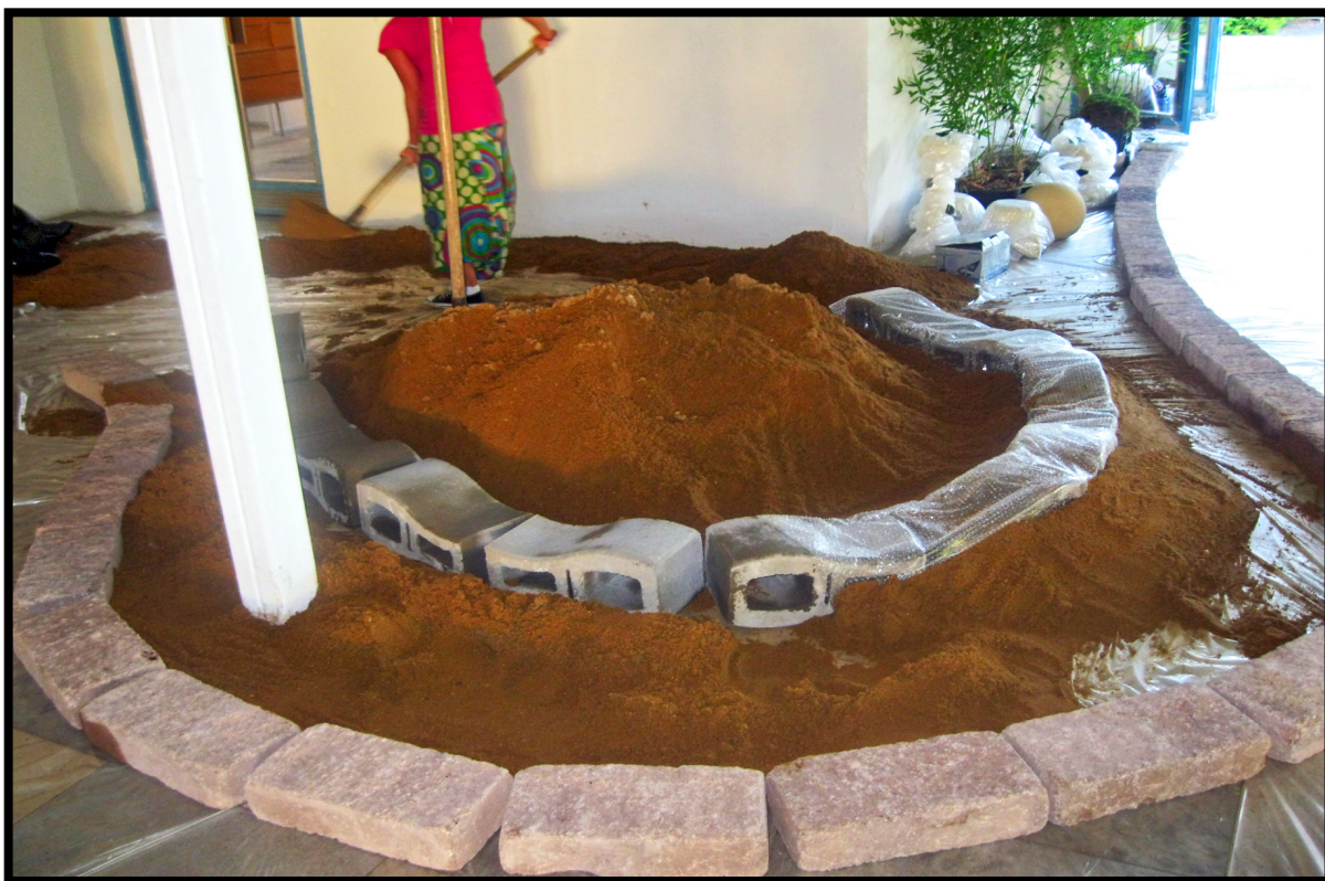
Foto č. XXV. - Pohled na tvarování jezírka z písku a cihel firmy KB Blok (Pondělí 2011)
