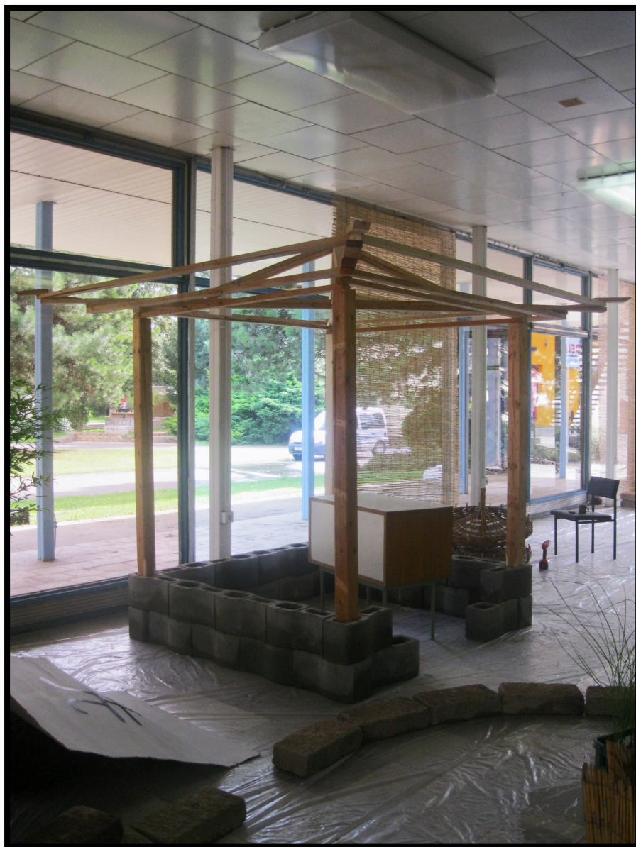
Obrázek č. XXVIII. - Stavba stylizovaného japonského altánu (Úterý 2011)
