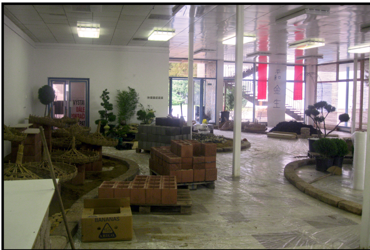
Obrázek č. XXIX. - Celkový pohled na rozestavěný pavilon D (Úterý 2011)
