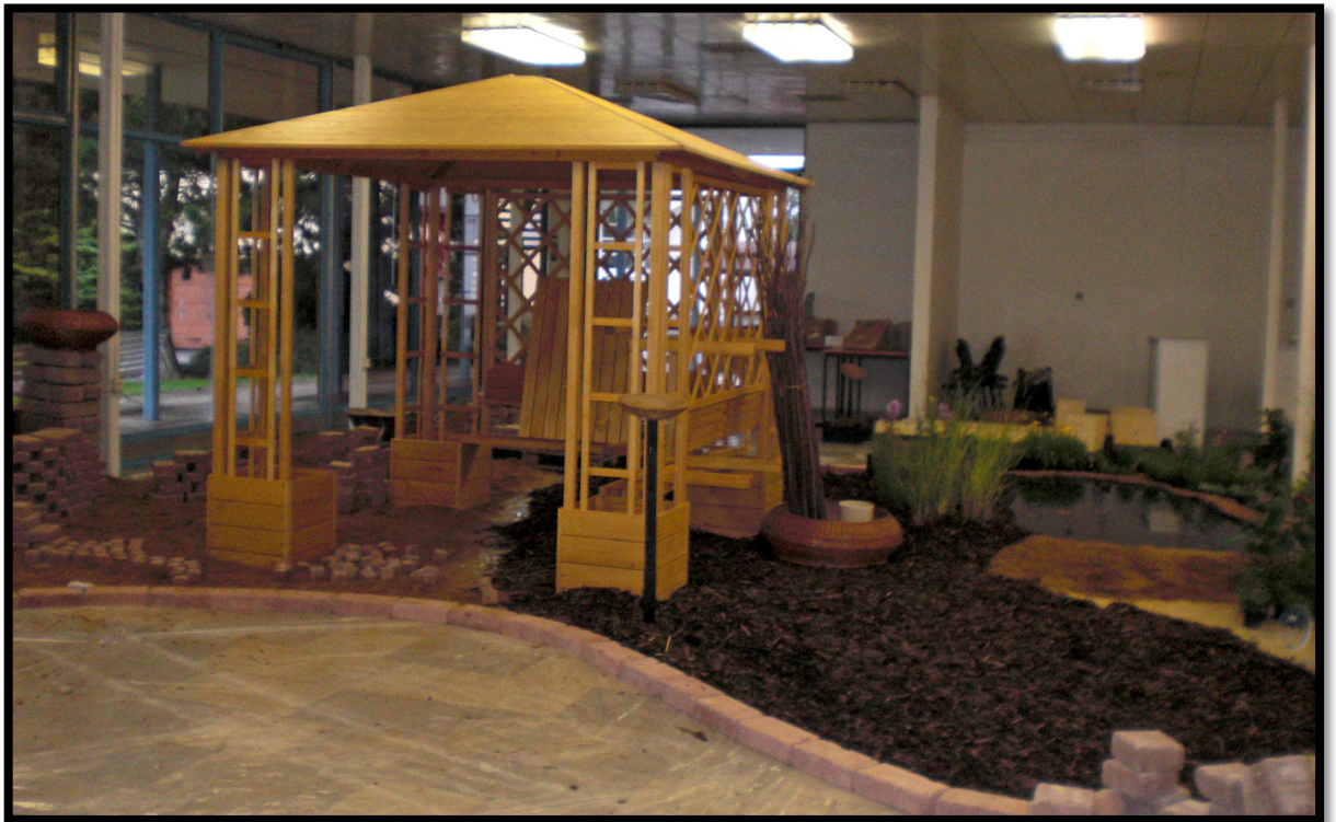
Obrázek č. XII. - Stavba altánu, stavba okopávek, zídek (Úterý 2010)
