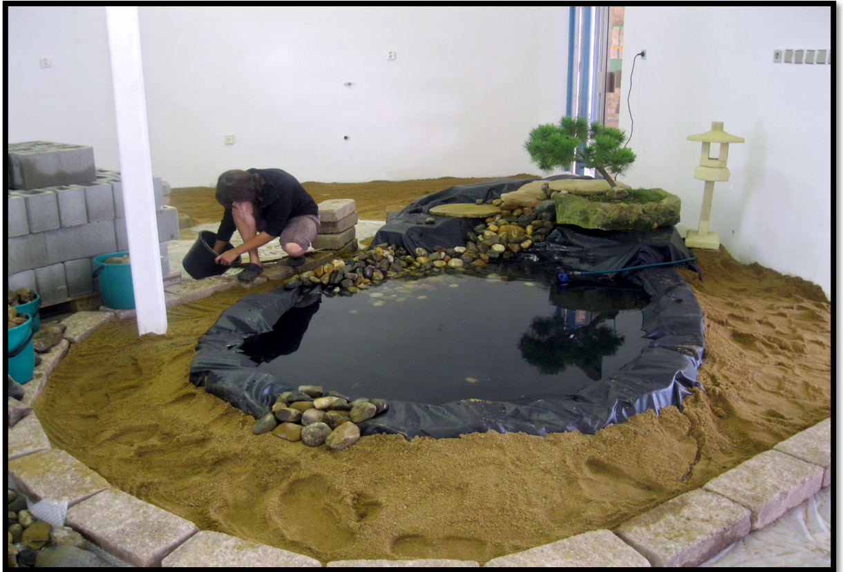
Obrázek č. XXVI. - Pokračování stavby jezírka (Úterý 2011)
