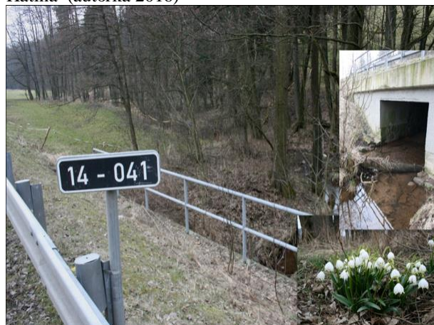
Obr. 5.4.5 Propustek pod silnicí I. Třídy – vodní tok Hatina (autorka 2016)
