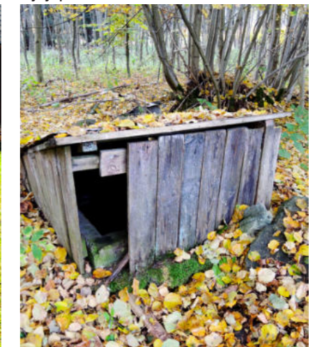
Obr. 133, Kryt původní studny
