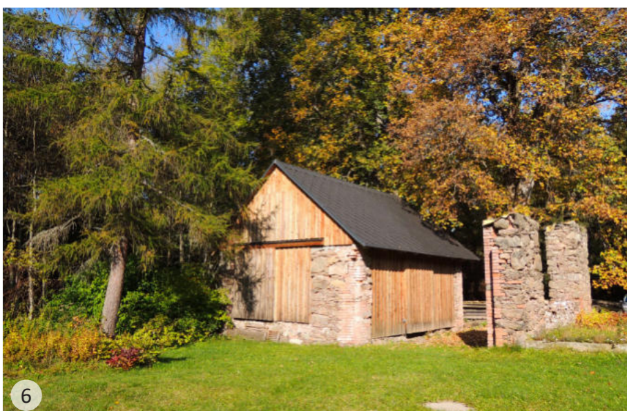
Obr. 92, Stodola po opravě, s využitím zdí původního objektu, zdroj: autor
