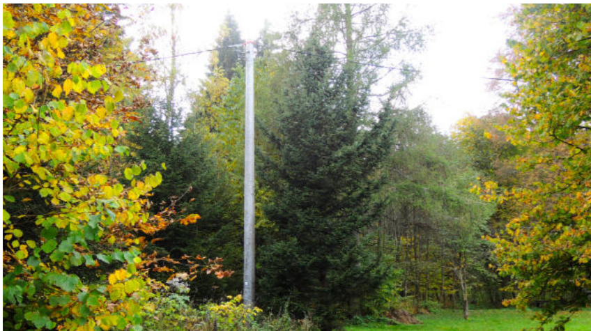
Obr. 125, Sloup s nadzemním elektrickým vedením, v jižní části zahrady
