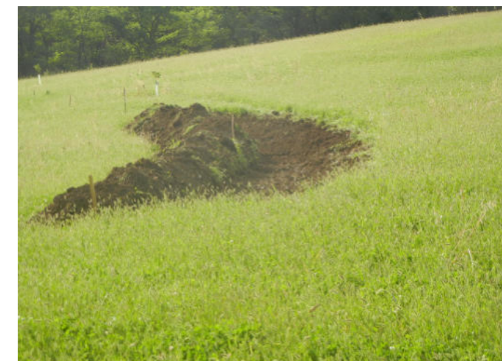
Obr. 182, Vsakovací průleh - reference 2, zdroj: viz kap. 09
