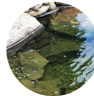
Obr. 199, Lámaný kámen pro zpevnění okrajů jezírka
