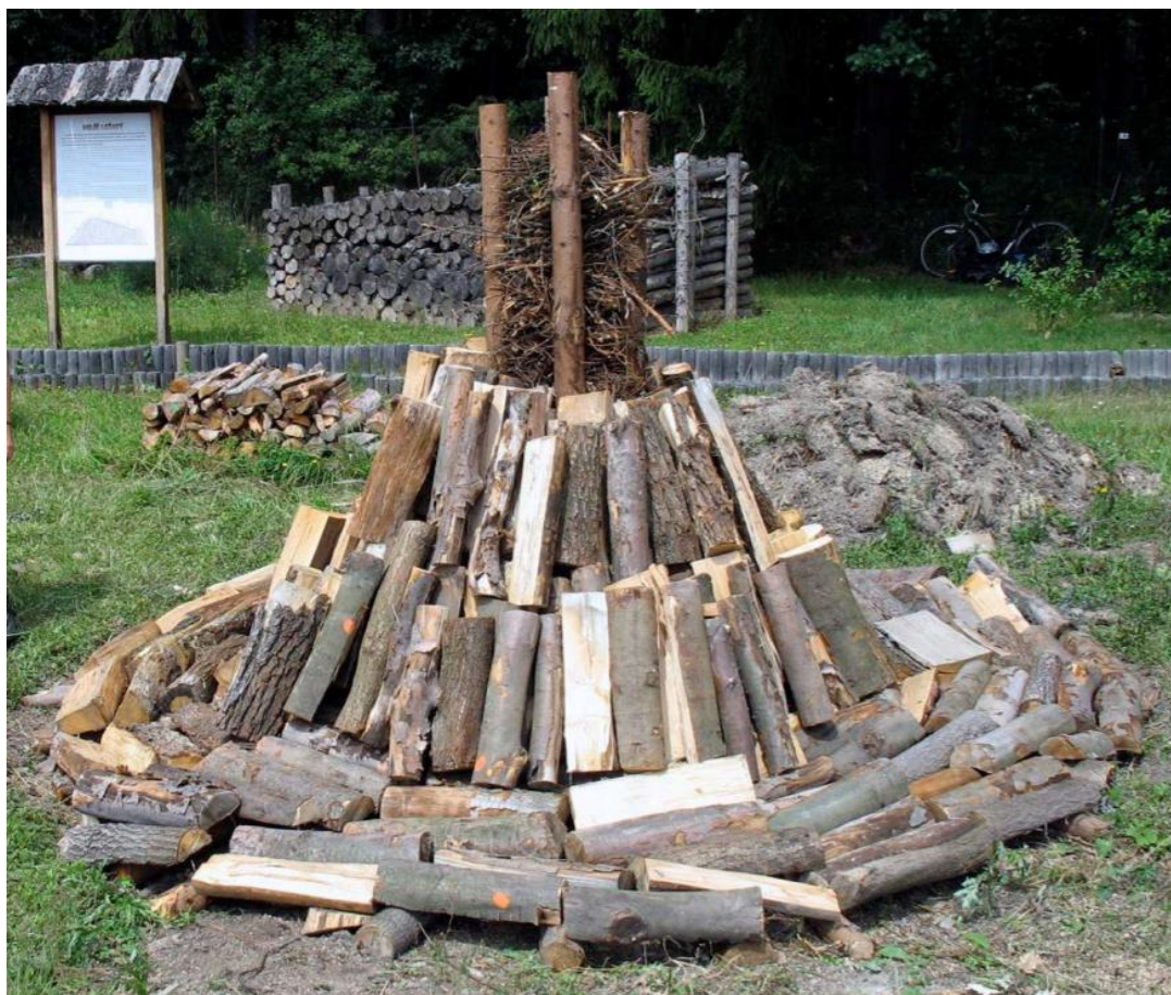
Obrázek 10: Experimentální pálení milíře – rovnání polen, uprostřed hromady je zápalný kanál (Cyrus a Matoušek 2009).
