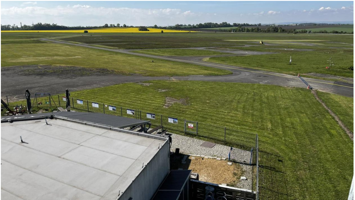
Obr. č. 12 Pohled na oplocení neřízeného letiště
