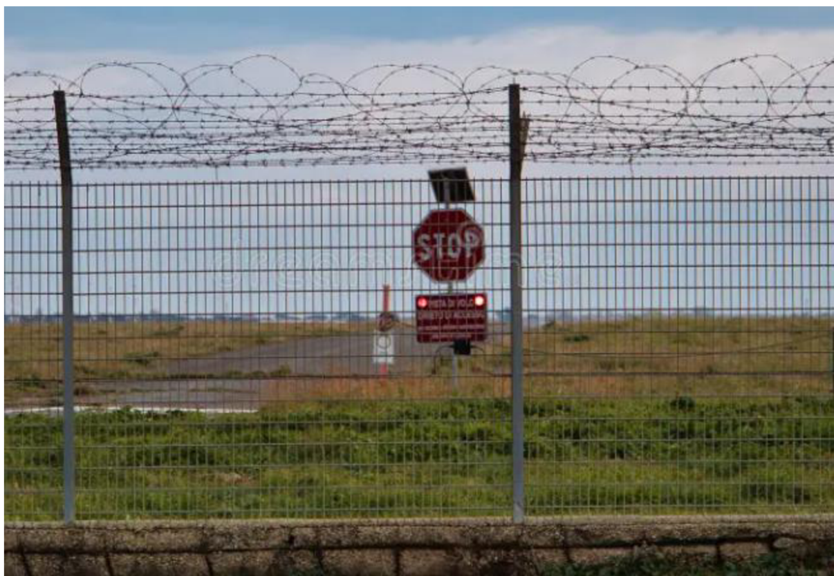
Obr. č. 14 Oplocení řízeného mezinárodního letiště [53]
