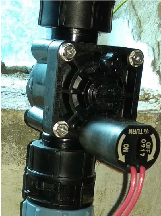
Obr. 44 Detail na elektromagnetický ventil
