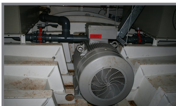
Obr. 10 Asynchronní elektromotor
