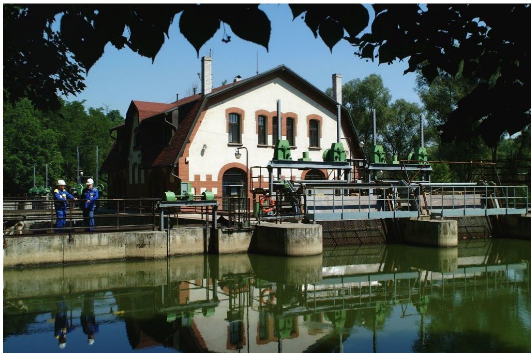
Obr. 3 - Vodní elektrárna Želina na řece Ohři – pro rekonstrukci (www.cez.cz)
