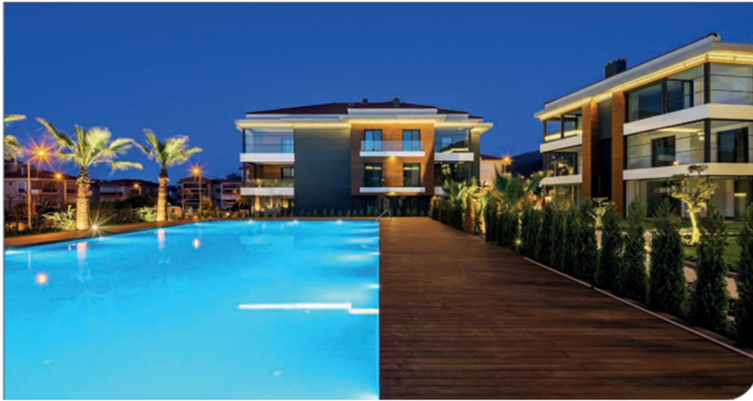
Obrázek č. 7 - Využití ThermoWoodu pro terasovou podlahu v areálu hotelu v Turecku (Lahtela, 2021)
