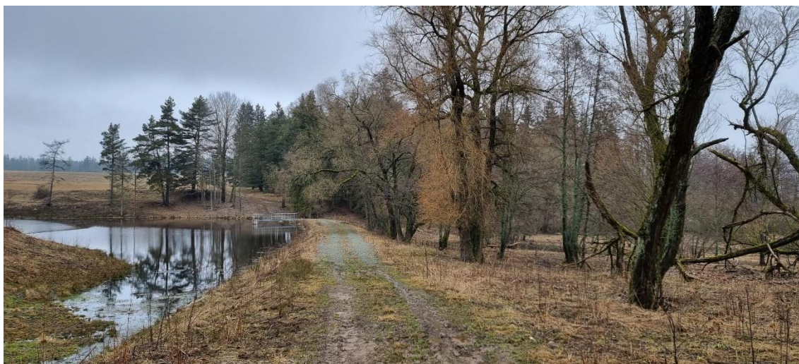
Obrázek č. 6: Hráz Dřevohryzského rybníka po revitalizaci posunutá na úroveň severní cesty z obce (Zdroj: vlastní archiv autora)
