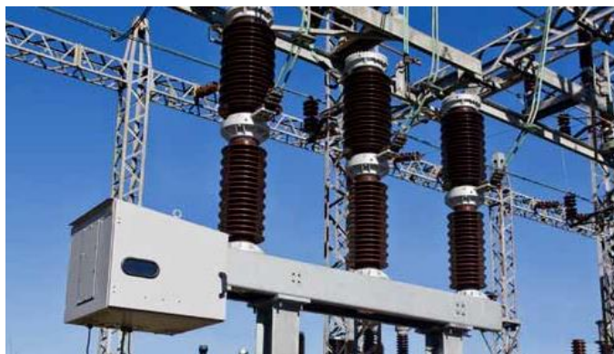
Obr. 3.4 Vypínač 3AV1FG 72.5 kV od spoločnosti Siemens [7].
