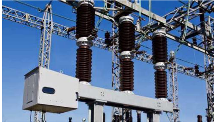
Obr. 3.4 Vypínač 3AV1FG 72.5 kV od spoločnosti Siemens [7].
