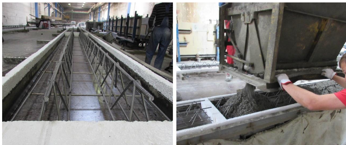
Obr. 102: Filigránový nosník - bednění s výztuží a výroba nosníku
