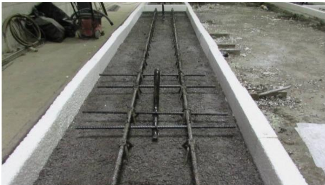
Obr. 103: Povrch filigránového nosníku před dobetonávkou horní vrstvy
