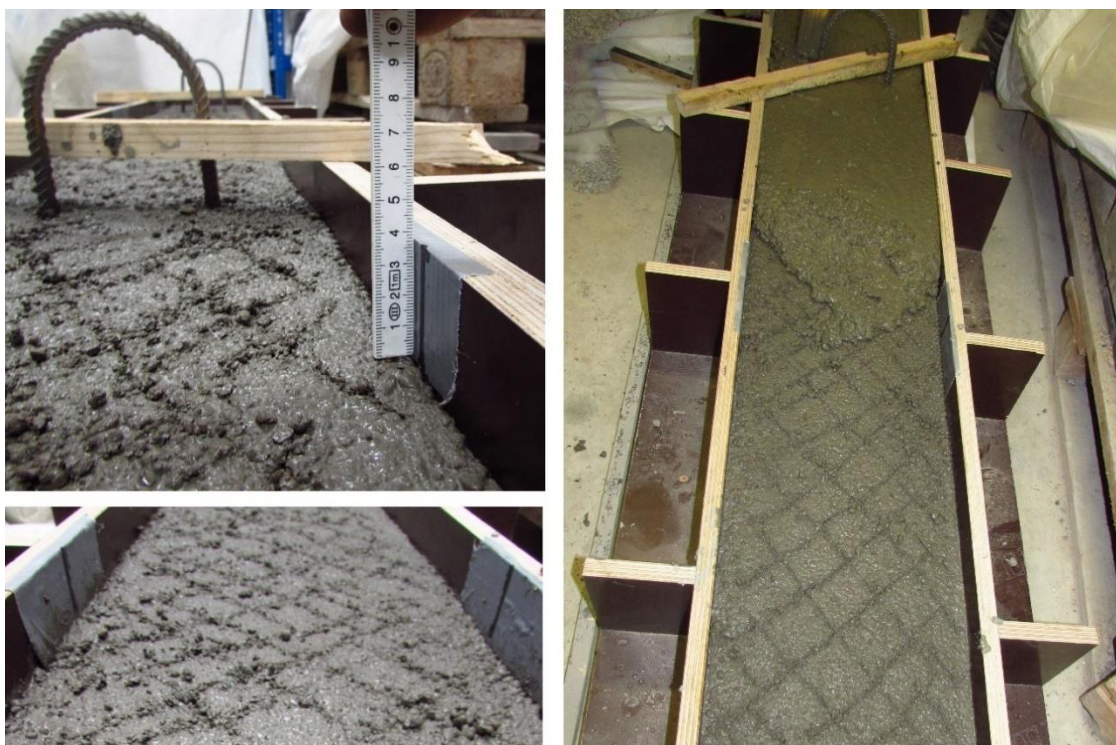
Obr. 94: Úprava pracovní spáry zdrsněním a dobetonávka vrstvy z běžného betonu
