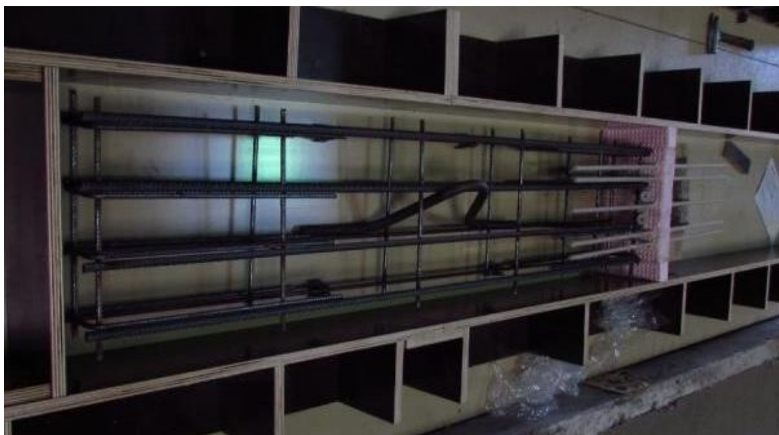
Obr. 107: Bednění balkonového nosníku s vloženým izo prvkem
