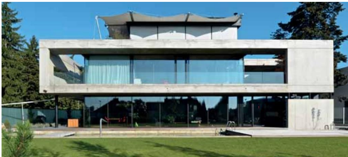
Obr. 14: Teprve druhá významná realizace rodinného domu z lehkého betonu [28]
