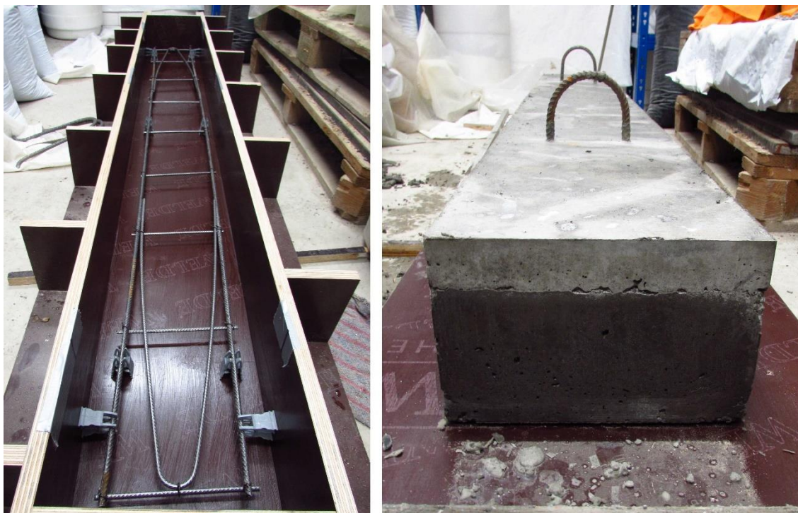
Obr. 95: Bednění s vloženou výztuží a povrch vrstveného nosníku po odformování
