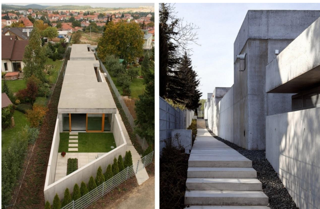
Obr. 13: Liaporbetonové domy Brno Žebětín
