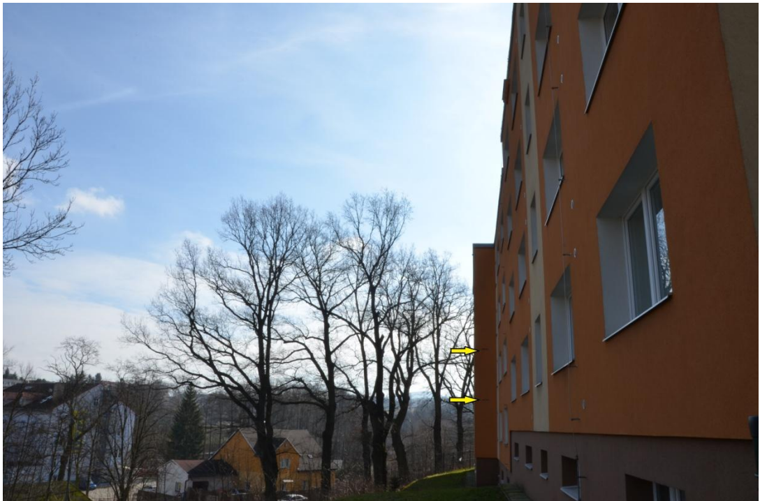
Foto č. 20: Sídliště Doubí – budky na panelovém domě č. p. 392 – 394
