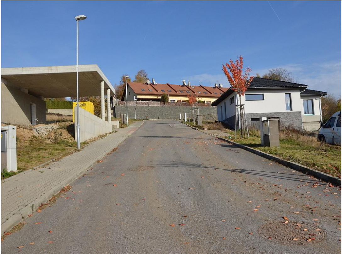
Foto č. 11: Satelit Na Rudě – pohled na novostavby (S)
