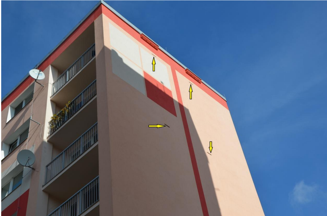
Foto č. 21: Sídliště Vesec - budky na panelovém domě v ulici Holubova (č. p. 512/9)
