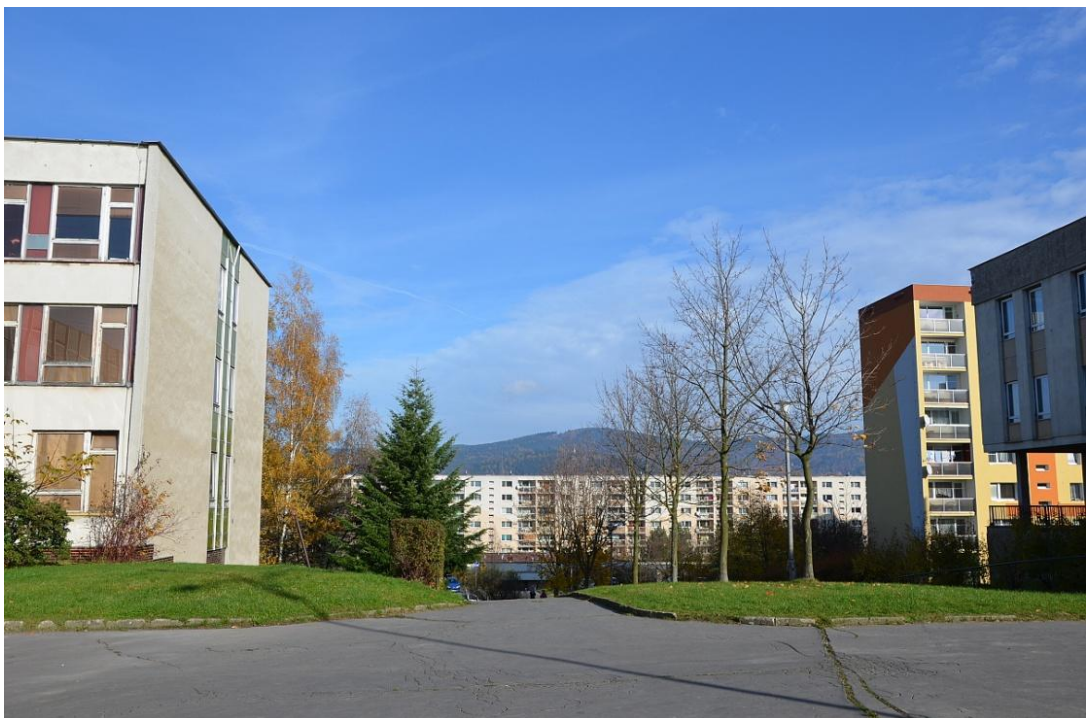
Foto č. 8: Sídliště Broumovská – pohled k SZ
