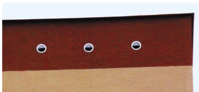
Obr. č. 26: Kruhové průletové otvory, které jsou z části zakryté mřížkou (Schnitzerová a kol. 2009).
